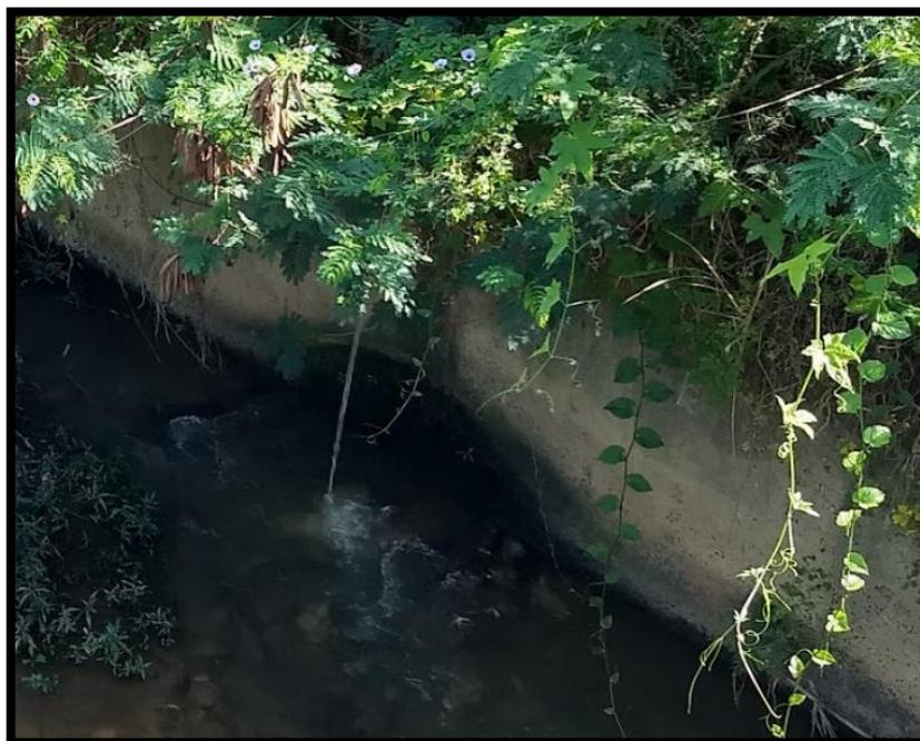
Foto 7.1.3 – Tubo de drenagem contaminado com esgoto
