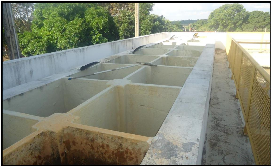
Os flocos que se formaram na etapa de aglutinação, nos floculadores, passam aos tanques de decantação aonde vão para o fundo por ação da gravidade. A água, já apresentando aspecto mais límpido, verte através de aletas dispostas na parte superior dos decantadores e, coletada através de canais, é encaminhada para a próxima etapa.
