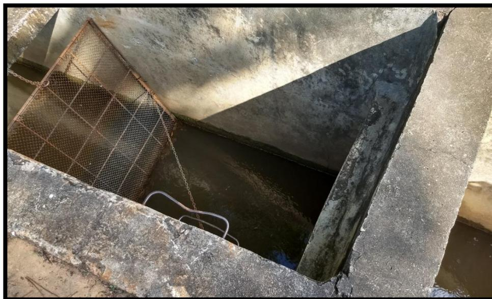
Do canal de adução a água passa por tubulação enterrada, para atingir o poço de sucção da Estação Elevatória de água bruta.
