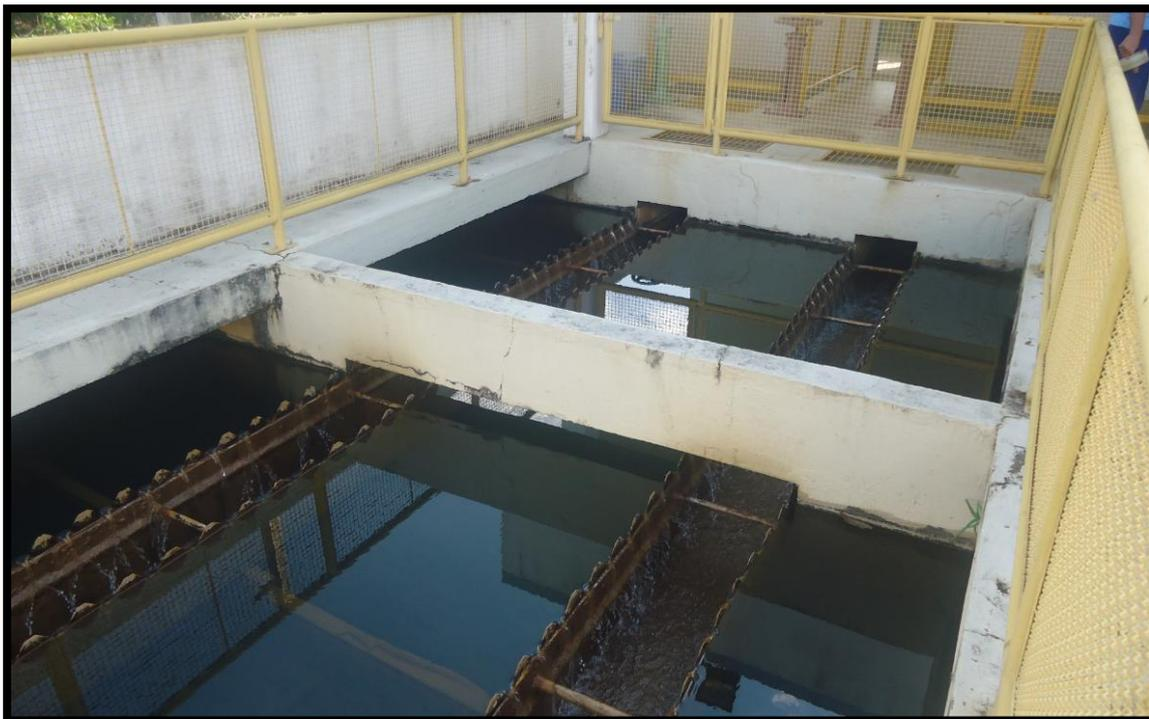
Mesmo com a remoção de impurezas nos processos combinados de floculação e decantação e com a água não mais apresentando o aspecto turvo original, ainda existem impurezas que são imperceptíveis ao olho humano. Há a necessidade, portanto, de retirá-las, o que é feito através da passagem da água através de materiais dispostos em camadas de granulometria variável, de maneira a que cada uma destas camadas retenha as impurezas de determinada dimensão.
