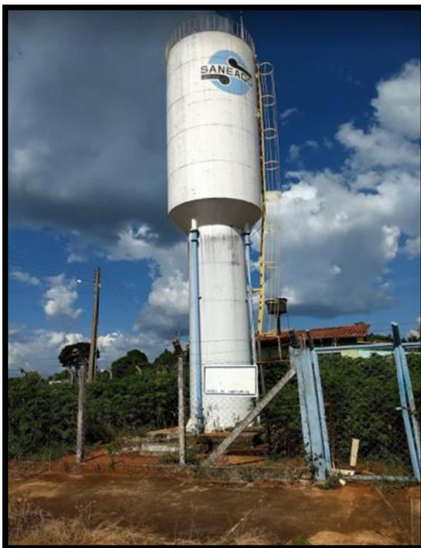
A EEAT da ETA, a partir do dois reservatório de 450 m<sup>3</sup>, abastece também o REL em concreto do bairro Boa Vista, situado em cota mais elevada. Composta por 2 conjuntos moto-bomba de 50 cv, sendo 1 de reserva, AMT 10 mca e vazão de 72,22 l/s. Funciona 21 horas por dia.
