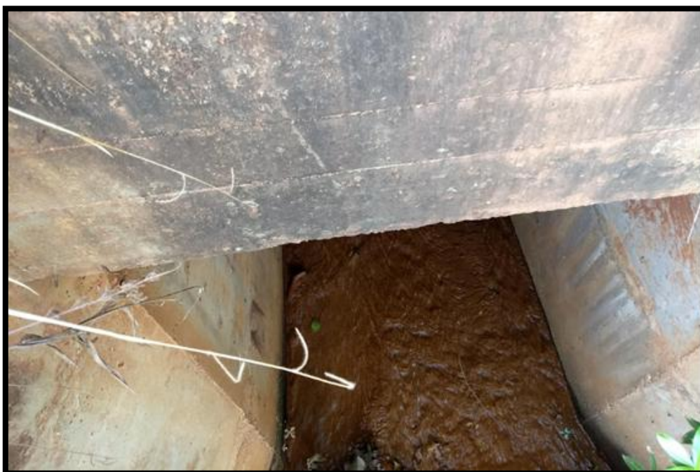
Foto 12.1.6 – Córrego da Divisa – Ponto de travessia sob linha férrea
