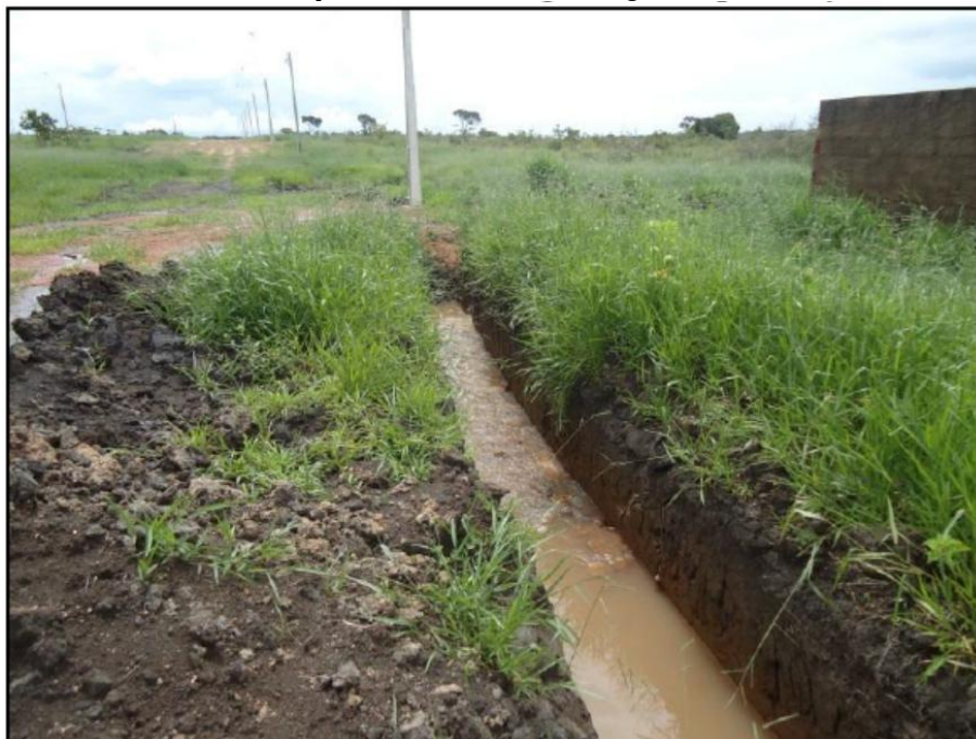
Foto 8.2.2 – Utilização de valas de drenagem sem revestimento
