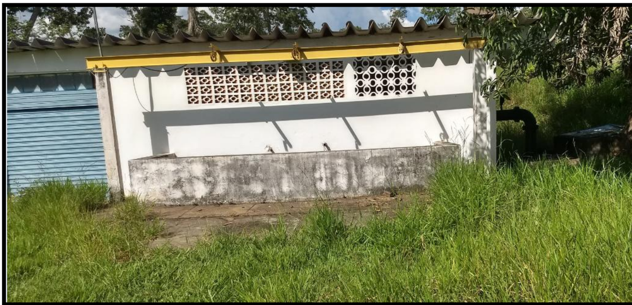
Foto 6.1.6 – Vista da EEAB desde a captação
