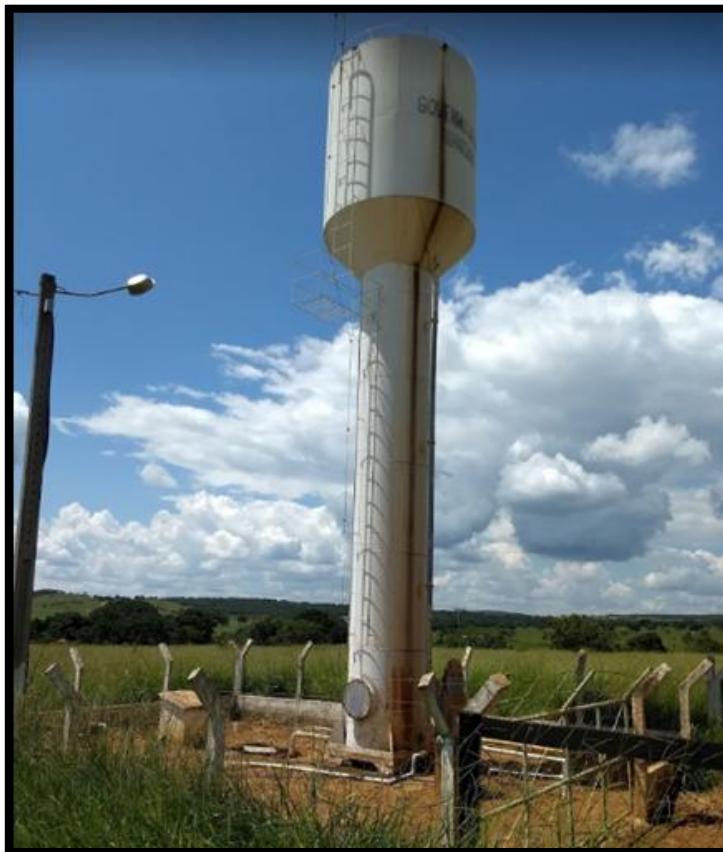
Foto 6.3.2 – REL 30 m3 e poço de Cavalheiro
