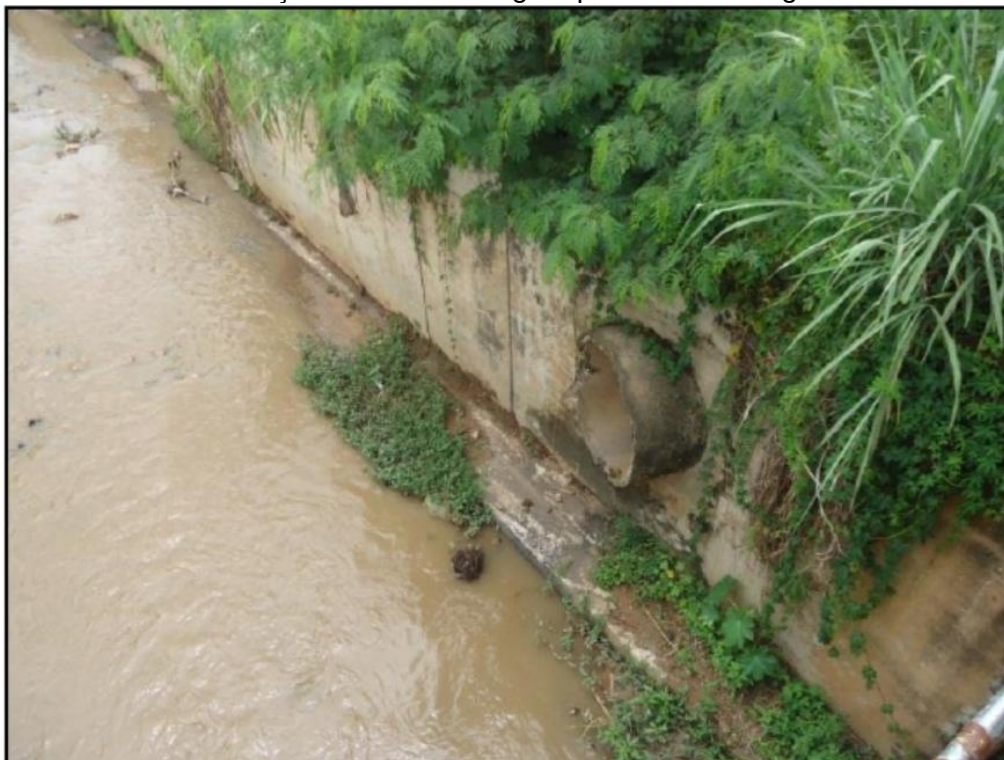
Foto 8.1.6 – Lançamento de drenagem pluvial no Córrego Vai-e-vem
