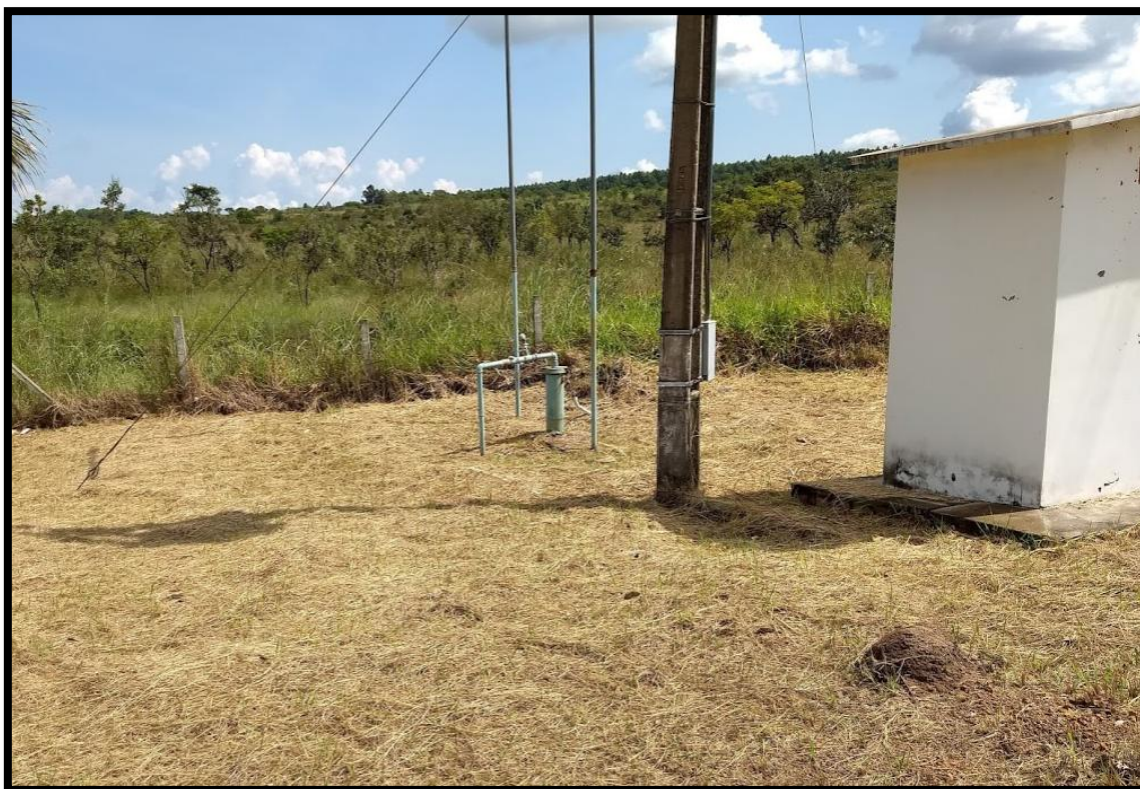
Foto 6.2.2 – Captação em poço 10 m 3 /h – Domiciano Ribeiro
