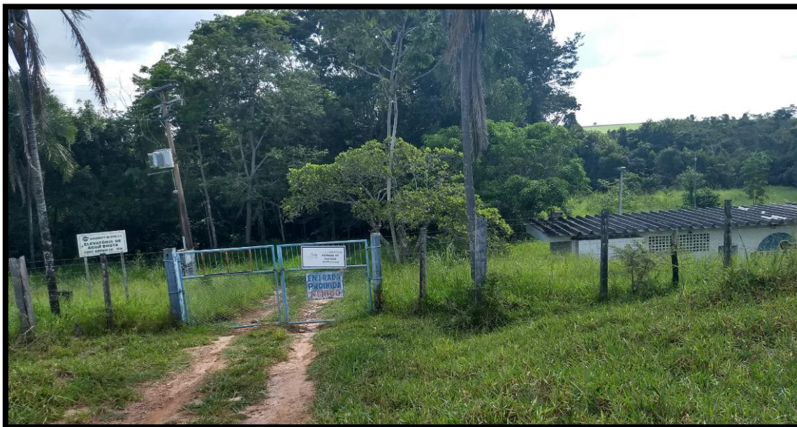
Foto 6.1.1 – Chegada à área da captação
