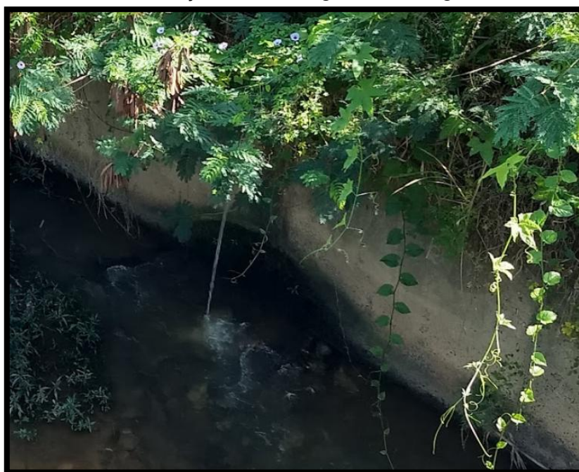
Foto 7.1.2 – Lançamento de esgoto no córrego Vai-e-vem
